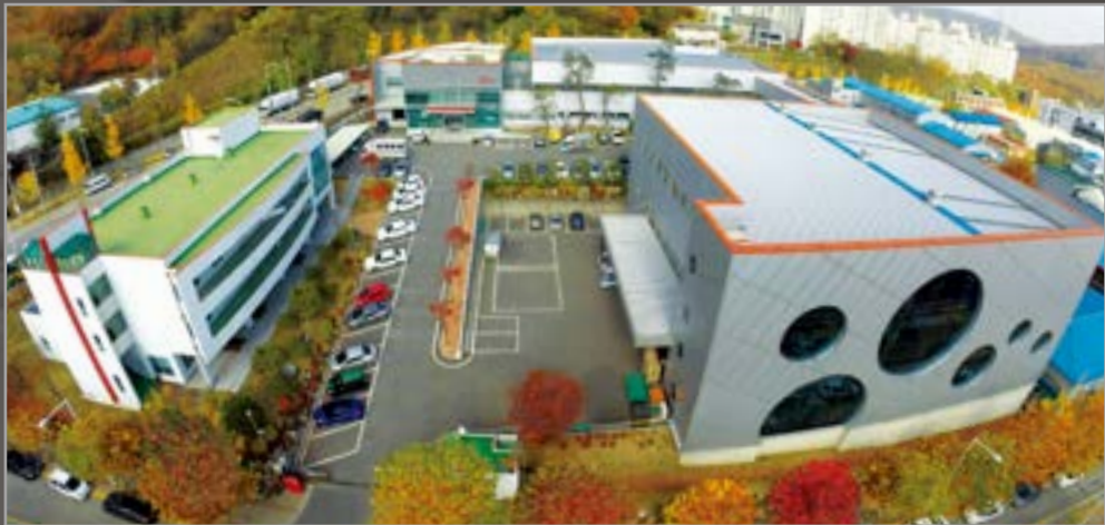
아카데미과학 본사 및 공장 전경
